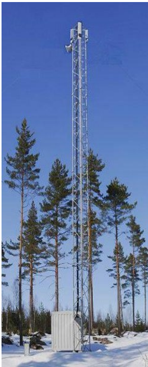
Antennbärartyp: 3-sidigt fackverkstorn Ostagat
