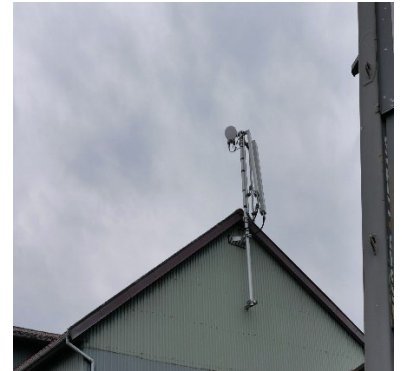
Antennbärartyp: byggnad vägg
