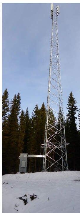
Antennbärartyp: 4-sidigt fackverkstorn Ostagat
