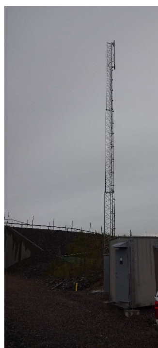
Antennbärartyp: 3-sidigt fackverkstorn Ostagat
